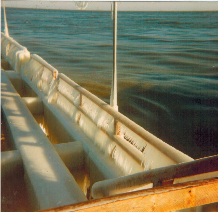
Göhrener Seebrücke vereist
